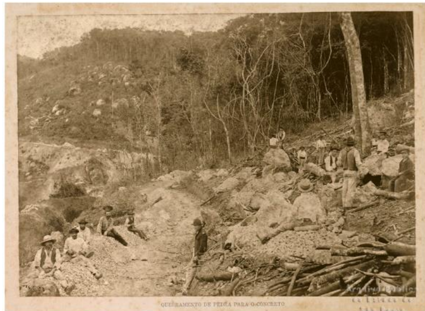
Figura 27 – “Quebramento de pedra para o concreto”. Pierre Doumet, 1893. Fonte: APESP - Arquivo Público do Estado de São Paulo. Acervo Digitalizado: Iconográfico: Álbum Águas e Esgotos. Disponível em: < http://www.arquivoestado.sp.gov.br/web/digitalizado/iconografico/aguas_esgotos >. Acesso em: 9 jul. 2021.
