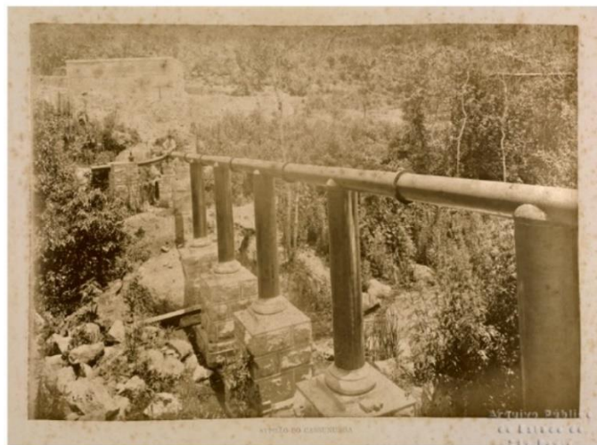
Figura 24 – Fotografia do sistema para captação de águas mostrando o “Sifão do [córrego] Cassununga”. Pierre Doumet, 1893. Fonte: APESP - Arquivo Público do Estado de São Paulo. Acervo Digitalizado: Iconográfico: Álbum Águas e Esgotos. Disponível em: < http://www.arquivoestado.sp.gov.br/web/digitalizado/iconografico/aguas_esgotos >. Acesso em: 9 jul. 2021.
