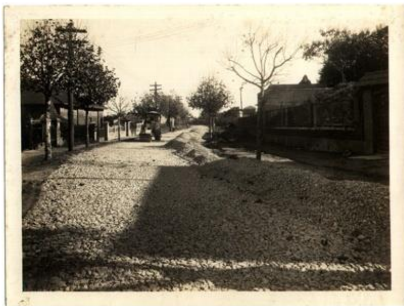
Figuras 75 e 76 – Processo de macadamização da Estrada da Cantareira, em 1928, ocorridas durante o mandato de José Pires do Rio. Fonte: Arquivo Histórico Municipal de São Paulo. Acervo Iconográfico. Imagens 0118 e 0119.
