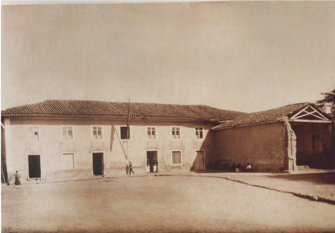
Figura 12- Sede da antiga Fazenda Santana, utilizada no final do século XIX como hospedaria para os imigrantes que chegavam ao Núcleo Colonial de Santana. Atualmente este edifício, na Rua Alfredo Pujol, abriga Centro de Preparação de Oficiais da Reserva de São Paulo (CPOR/SP), do Exército brasileiro. Fonte: (LEMOS, 2001).
