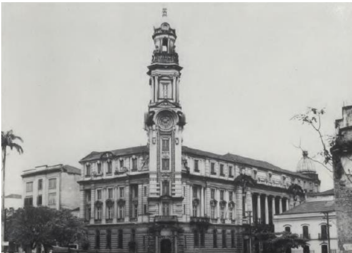
Figura 6: Fachada e torre do edifício da Bolsa de Café, vista da Rua Tuiuti. Foto de Hugo Segawa para o Condephaat. Ano: 1979. Disponível: CONDEPHAAT, 1974, Processo 421/74, fl. 111.
