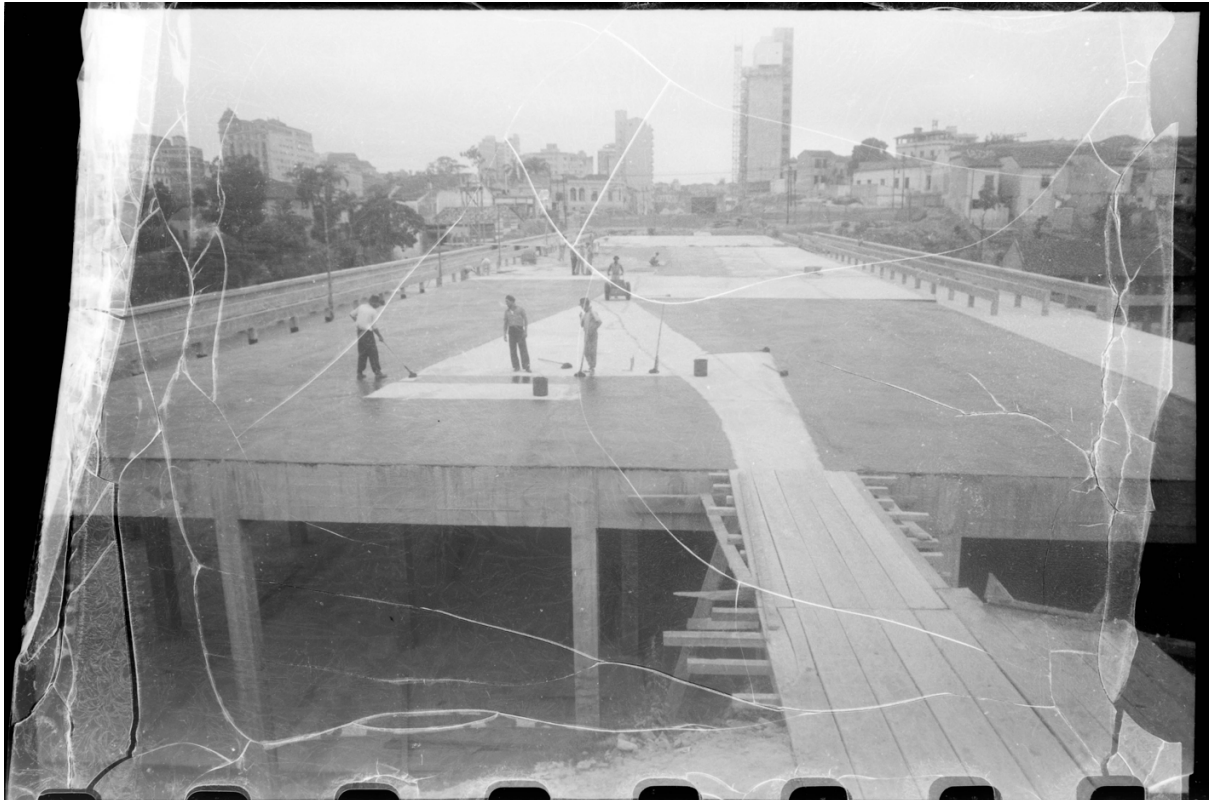
Figura 15. Fotografia registra a construção do Viaduto Jacaré, Esquina mais próxima: Rua Jacaré. Vide a planta de localização 3074-A. Revestimento de via carroçável do Viaduto Jacaré. DUARTE, Benedito Junqueira (BJ Duarte). Acervo Fotográfico do Museu da Cidade de São Paulo, 1942.
