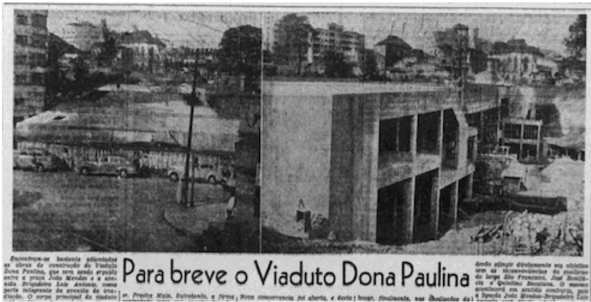
Figura 7. Artigo cobrindo as obras do Viaduto Dona Paulina. Fonte: Correio Paulistano, 1947.
