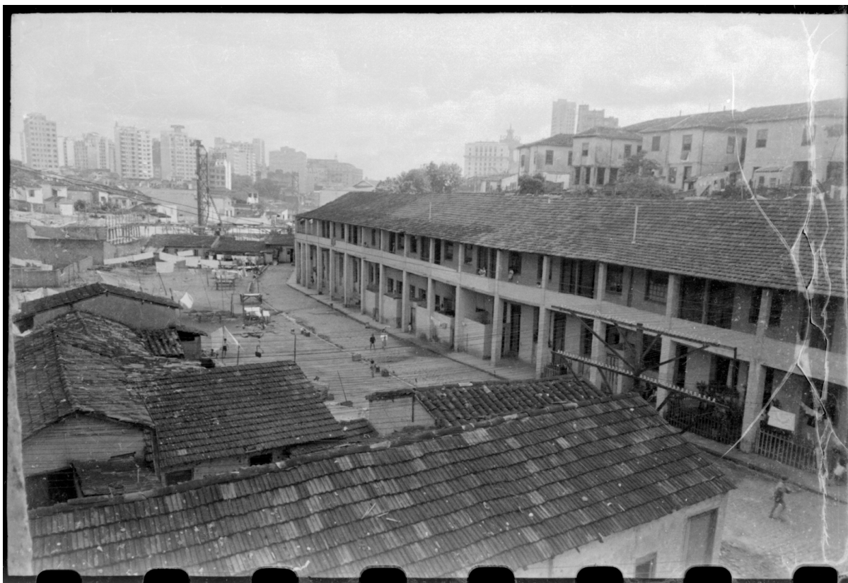
Figura 19. Fotografia da Rua Japurá, mostrando partes do cortiço Navio Parado, em sua extremidade para a Rua Jacareí. Em cima, aos fundos das casas da Rua Sto. Antônio e atravessando o Vale do Bexiga, as obras do Viaduto Jacareí – DUARTE, Benedito Junqueira, 1942. Acervo Fotográfico do Museu da Cidade de São Paulo.
