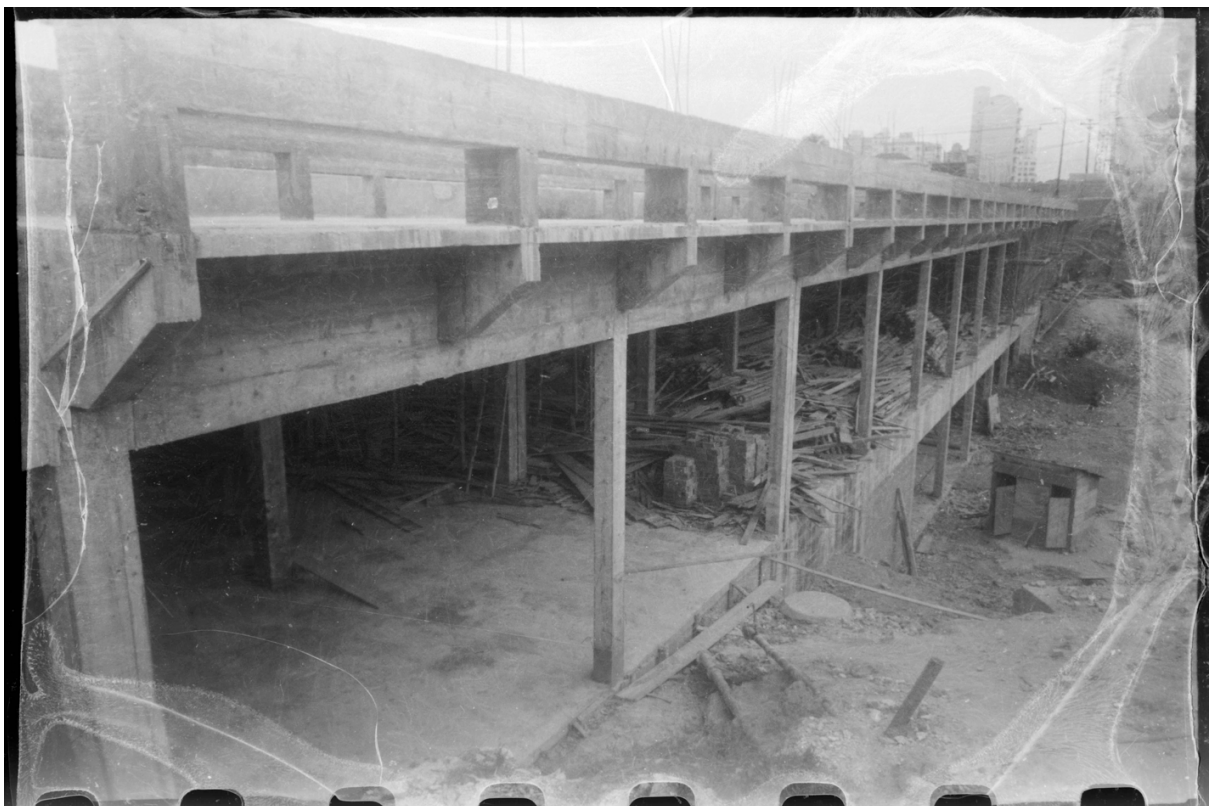
Figura 14. Fotografia registra a construção do Viaduto Jacareí, nas proximidades da rua de Santo Amaro. DUARTE, Benedito Junqueira (BJ Duarte). Acervo Fotográfico do Museu da Cidade de São Paulo, 1942.
