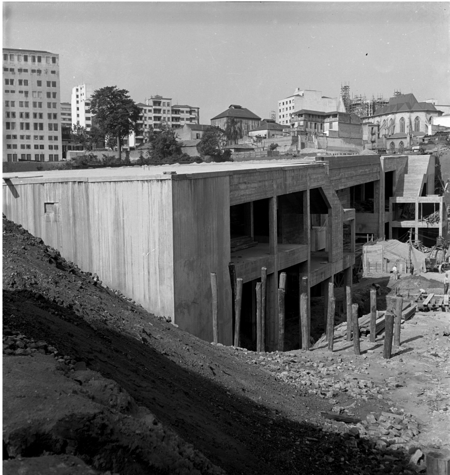
Figura 8. Fotografia registra a construção do Viaduto: Dona Paulina, ao fundo, vê-se a Catedral da Sé. FERREIRA, Sebastião de Assis. Acervo Fotográfico do Museu da Cidade de São Paulo, 1940-1950.
