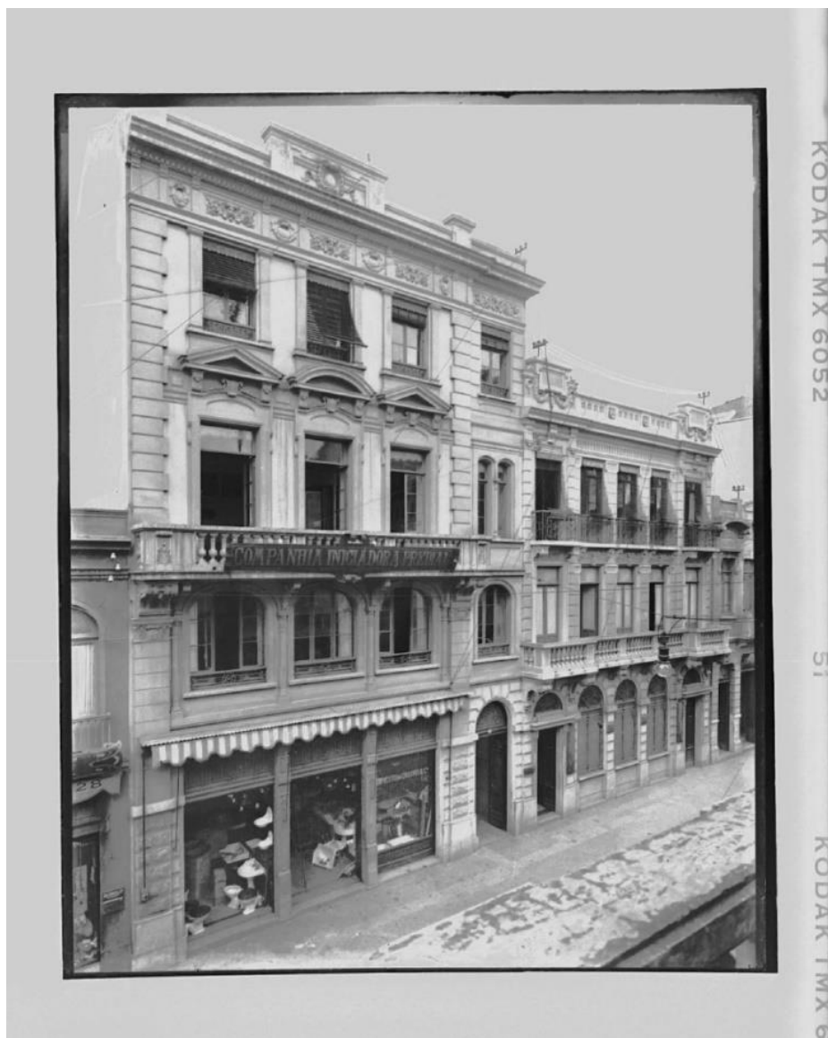
Fig. 42. No térreo a casa comercial Ernesto de Castro & Cia. e no balaústre do segundo andar, placa da Companhia Iniciadora Predial. Fonte: Acervo da Biblioteca da Faculdade de Arquitetura e Urbanismo da USP.
