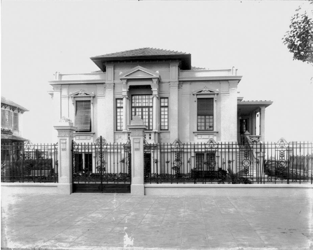
Fig. 15. Residência de Mário Dias de Castro situada à Avenida Paulista, 186. Fonte: Acervo da Biblioteca da Faculdade de Arquitetura e Urbanismo da USP, Fundo de Negativos do Escritório Técnico Ramos de Azevedo.
