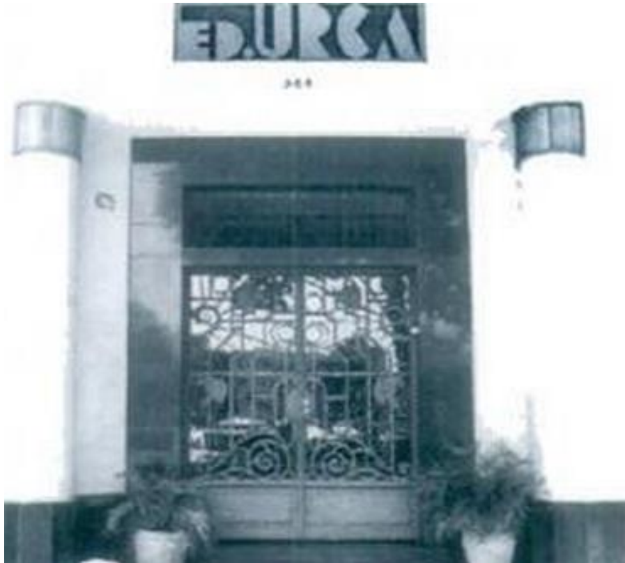
Figura 109. Fachada do Edifício Urca. Disponível em: CZAJKOWSKI, Jorge. Guia da Arquitetura Art Déco no Rio de Janeiro . 3. Ed. Rio de Janeiro: Casa da Palavra: Prefeitura da Cidade do Rio de Janeiro, 2000. pp.70.
