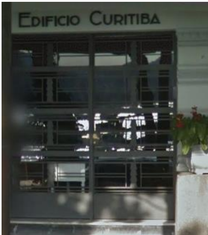
Figura 108. Portão do Edifício Curitiba. Disponível no link https://www.google.com.br/maps/-22.9500187,-43.16769,3a,75y,113.31h,87.99t/data=!3
