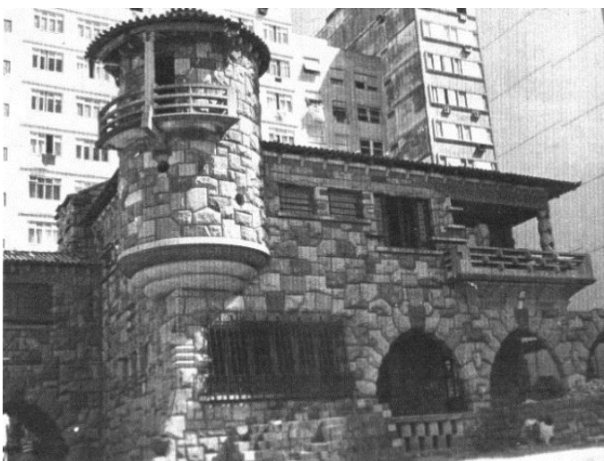
Figura 33. Aspectos da Casa Marajoara de Copacabana, antes da demolição. Fotografias de James Lawrence Vianna. Acervo de Fernando Atique.
