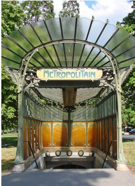
Figura 27. Estação de metrô em Paris. Disponível em https://br.pinterest.com
