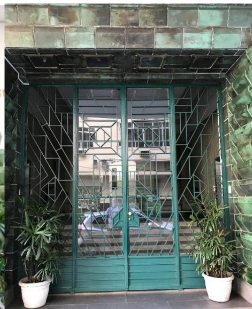
Figura 37. Edifício Itaoca. Detalhes da geometrização do portão. disponível em: Acervo de Fernando Atique, 2018.
