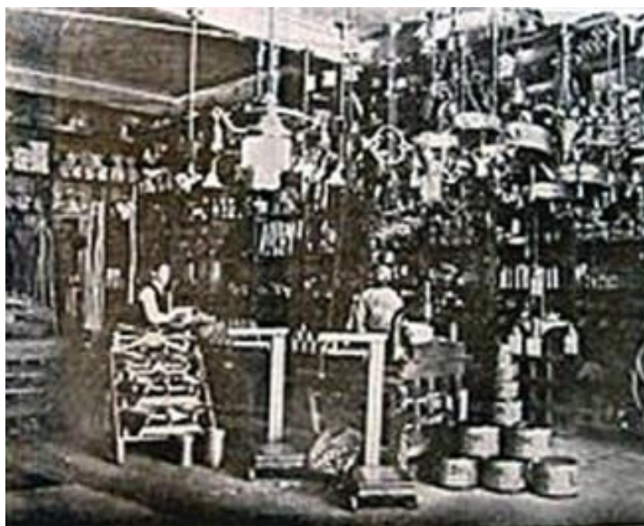
Figura 2- Funcionários Trabalhando na Casa da Boia. Fonte: Arquivo Casa da Boia.
