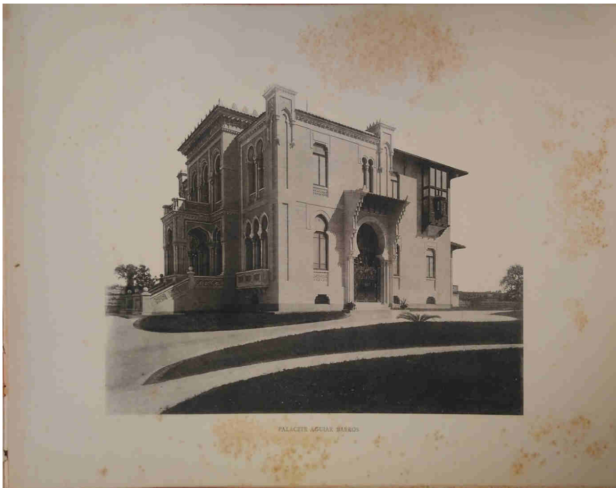
Figura 40. Palacete Aguiar de Barros. Posição 49 Fonte: Acervo de Obras Raras da Biblioteca da FAU-USP
