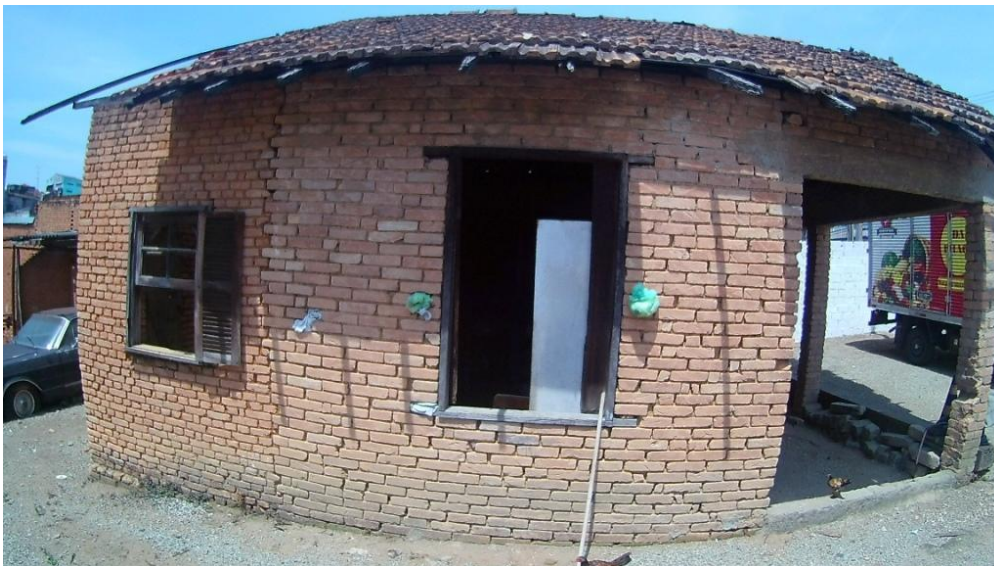
Figura 28. Lateral da antiga olaria construída no ano de 1928. Arquivo pessoal de Fernando Costa.
