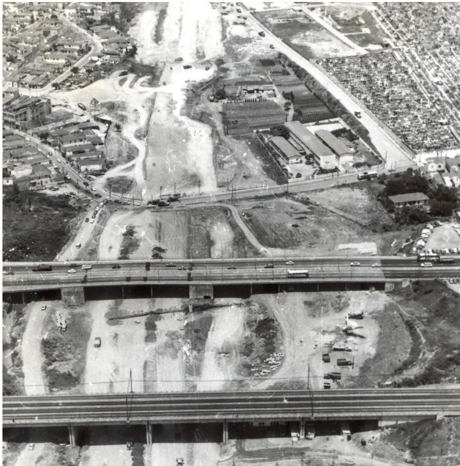
Fig. 8 e 9 - As imagens acima mostram a construção da Radial Leste, no final da década de 1970.
