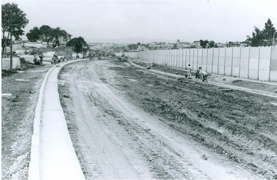
Fig. 10 - Construção do Viaduto Itinguçu que liga Artur Alvim à Vila Ré, por cima da Radial, na década de 1980.
