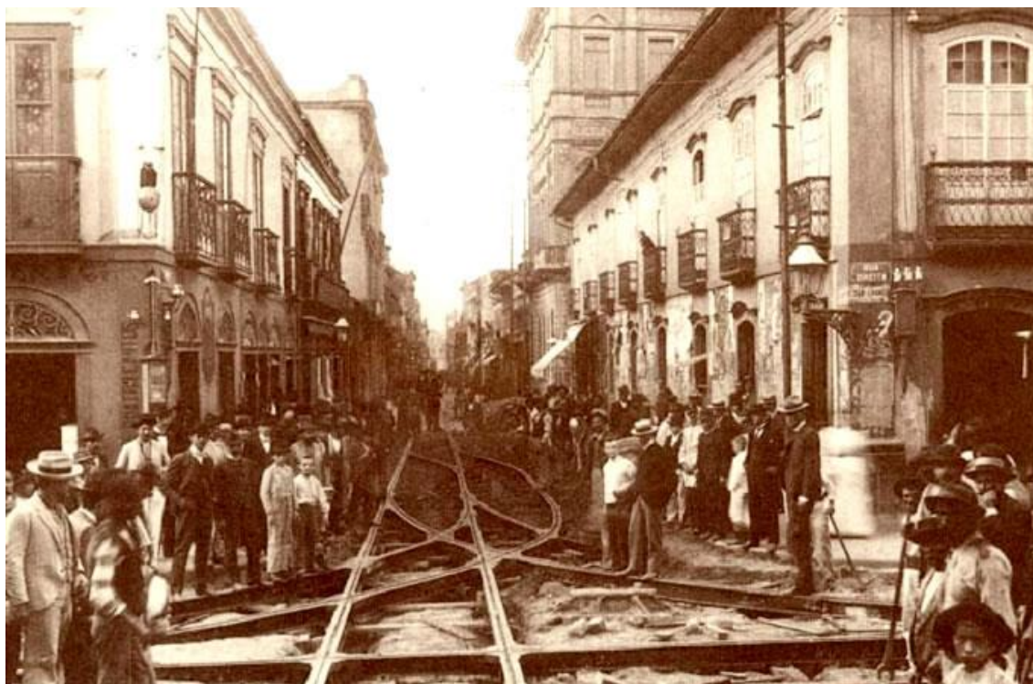
Fig. 1 - Colocação de trilhos de bondes na Rua Direita com Rua São Bento, em 1900.
