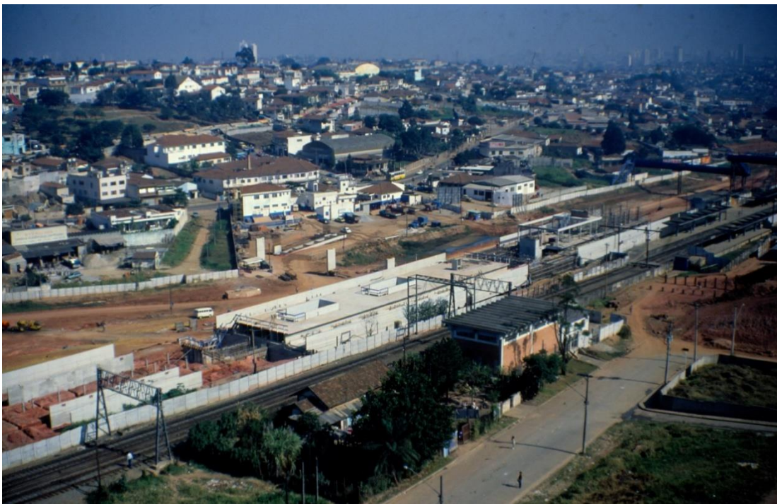
Fig. 13 - Estação Patriarca na década de 1980. Fonte: Arquivo da Companhia do Metropolitano de São Paulo.
