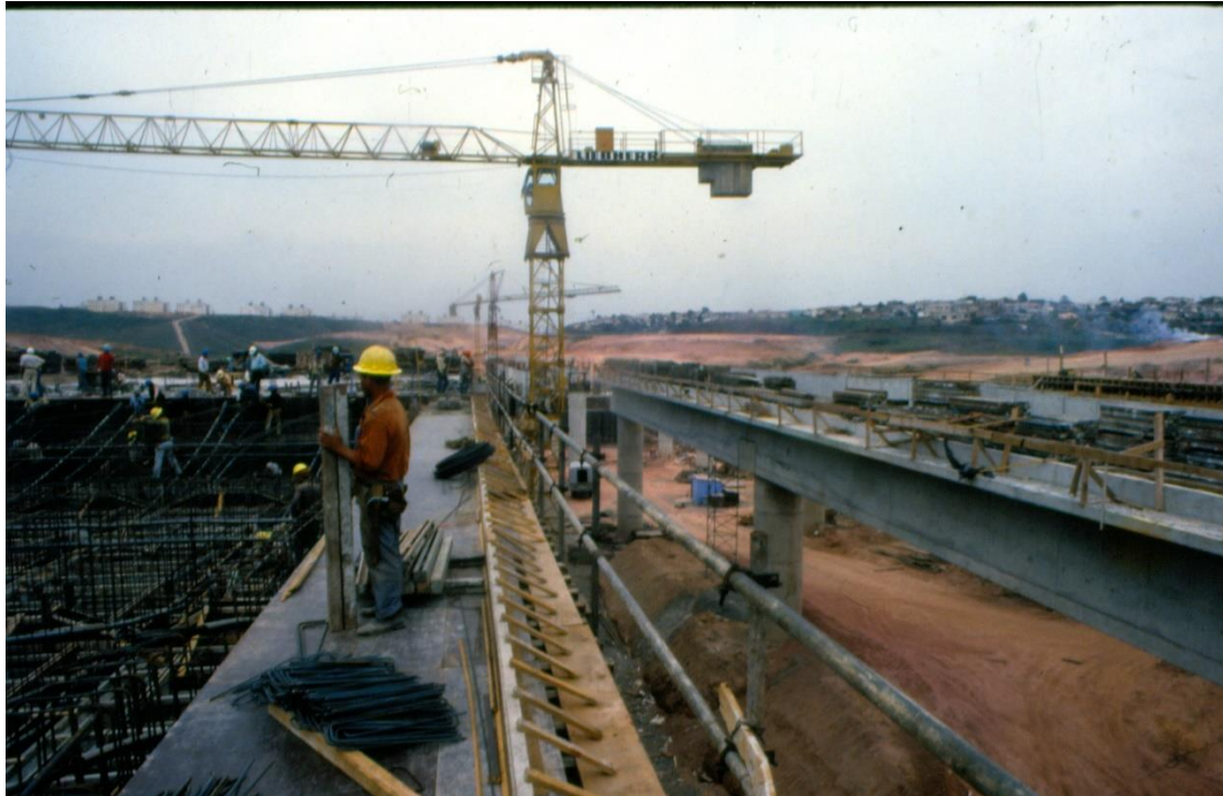
Fig. 12 - Estação Itaquera década de 1980, em obras. Fonte: Arquivo da Companhia do Metropolitano de São Paulo.
