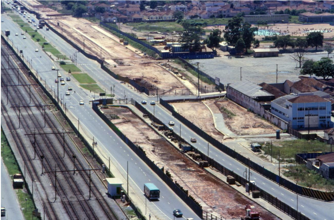
Fig. 16 - Região de construção da Estação Carrão na década de 1970.
