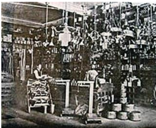
Figura 8- Funcionários Trabalhando na Casa da Boia. Fonte: Arquivo Casa da Boia.
