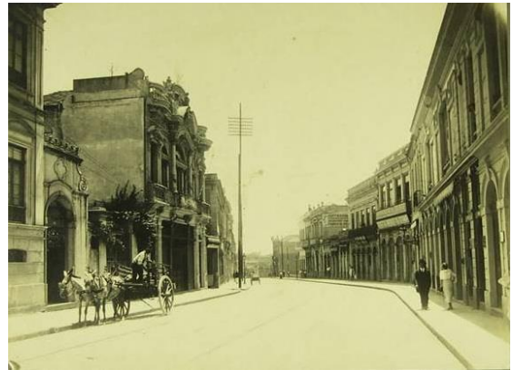
Figura 28 - Rua Florêncio de Abreu em 1914. Do lado esquerdo encontra-se a Casa da Boia. Fonte: Biblioteca Mario de Andrade.
