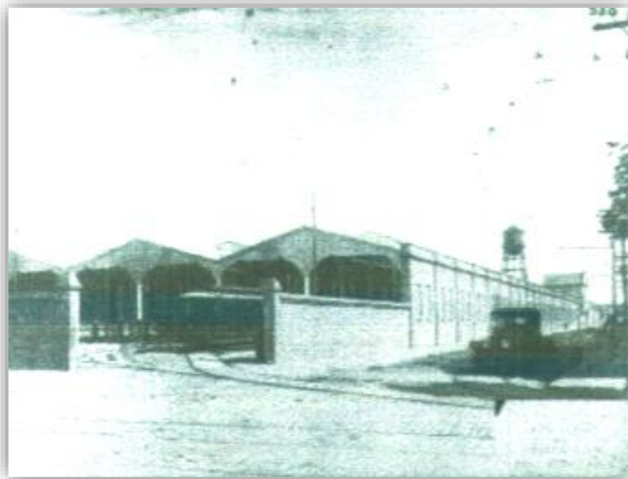
Figura 10: Entrada da Estação de Bondes, esquina da Av. Celso Garcia com Rua José de Alencar, 1913. . Fonte: Foto anexada ao parecer de 2005 de Marly Rodrigues no Processo de Tombamento da Estação de Bondes do Brás.
