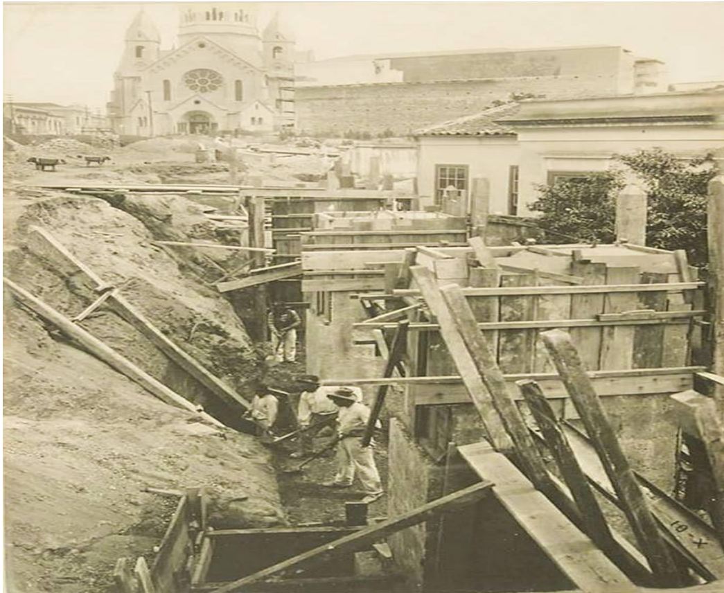
Figura 7: 1910- Início das construções para o Viaduto Santa Ifigênia. Sua estrutura metálica foi trazida da Bélgica. Atualmente é tombado pelo ConcrEsp, sendo um dos mais importantes remanescentes da Arquitetura de Ferro em São Paulo. Fonte: Acervo Particular
