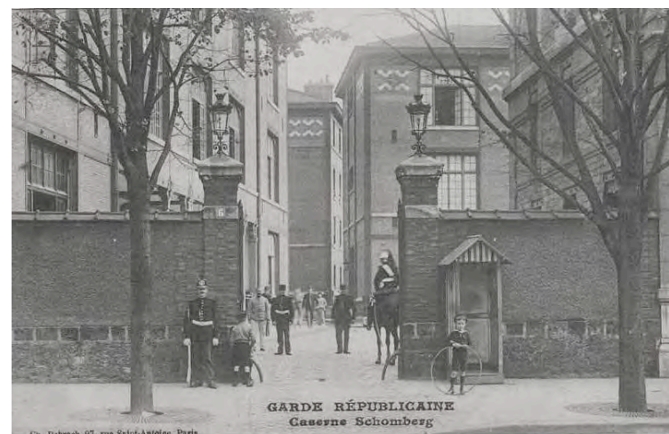
FIGURA 1.25 - Garde Républicaine. Caserne Schomberg . [s.d.]. Foi construída em 1861, abrigava três companhias de 130 homens. a partir de 1901, passou a ser escola da Guarda Republicana até ser danificada pelos bombardeios em 1944. Seu sistema construtivo constitui-se de armadura em metálica preenchida por alvenaria de tijolos. Cartão-postal datado, no verso, de 14 de janeiro de 1914. ( Garde Républicaine. Caserne Schomberg , [s.d.], Fonte: e-bay)
