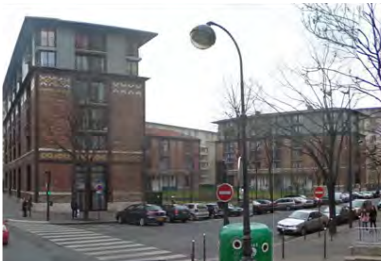
FIGURA 1.27 - Aspecto atual da Caserna Schomberg. 2010. Note-se que na remodelação empreendida recentemente, apenas os dois edifícios laterais sofreram o acréscimo de um novo pavimento. o Edifício intermediário, ao fundo, permanece com o gabarito do projeto original. (Imagem fonte: GOOGLEVIEW, 2010)
