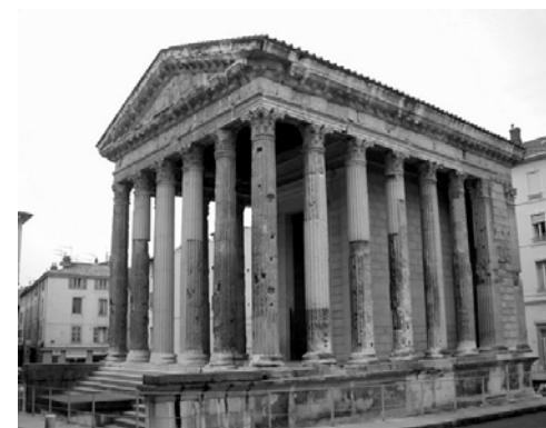
FIGURA 1.7 - O templo de Augusto e Lúvia em Vienne, França. (Fonte: ©GoogleStreetView, 2012. Acesso em 9.mar.2011)
