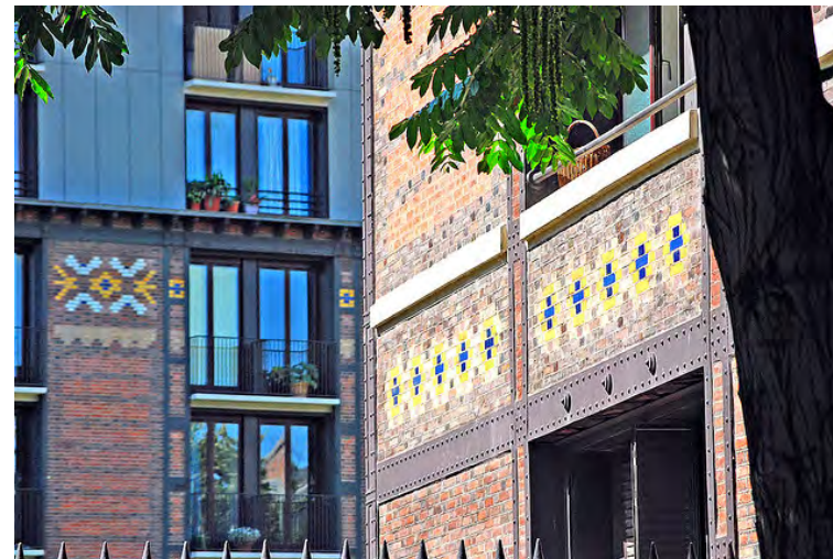
FIGURA 1.29 - Nicolas Jasson. Paris - boulevard Morland - ancienne caserne Schomberg, 2009. Aspecto atual da antiga Caserna Schomberg. Detalhe, onde se pode observar o sistema construtivo. (Fonte: ©JASSON, 2009)
