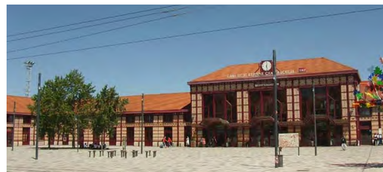
FIGURA 1.30 - Archiguide. Aménagement Esplanade de France. Urban development, avec AABD. 2008. Aspecto da Gare Châteaureux em 2008, após obras de reurbanização da esplanada à sua frente. Estrutura metálica e alvenaria de tijolos. Fotografia digital, cor. (Fonte: ARCHIGUIDE, 2008)
