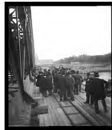
FIGURA 7.72 - Atelier Nadar. Visite du chantier de l’Exposition Universelle de 1900. Pont Alexandre III A comitiva inspeciona as obras da ponte Alexandre III. Fotografia em suporte de vidro. (Fonte: NADAR, 1900, , ©RMN)
