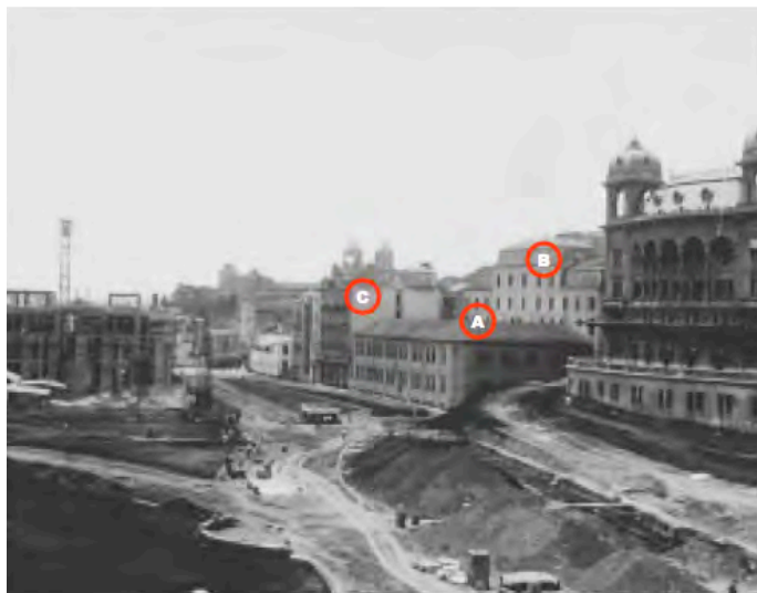
FIGURA 4.54 - Palácio da Prefeitura e parque do Anhangabá em construção. Detalhe em que se vê o edifício dos Irmãos Weiszflog reformado para atender às disposições surgidas com o projeto para as áreas do Anhangabá (A) e o novo edifício-sede da empresa em (B). Observar que o terreno do edifício A é encoberto pelo aterro geral da área, devido à implantação do parque. Álbum comparativo da cidade de São Paulo até o ano de 1916. Fotografia P&B, 1916. Acervo BMA
