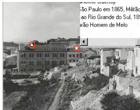
FIGURA 4.53 - Fundos da R. Líbero Badaró. Observar o imóvel pertencente aos Irmãos Weiszflog, edifício de 3 andares, com torreão de seção quadrada equipado com dois relógios em suas faces principais (A); e à sua direita, o edifício que seria demolido para reconstrução de nova sede (B). Essa reconstrução era objeto de pedidos de alinhamento por parte dos empresários e debates na Câmara Municipal. Álbum comparativo da cidade de São Paulo até o ano de 1916. Fotografia P&B, 1909. Acervo BMA
