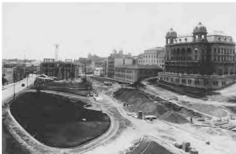
FIGURA 4.37 - Obras de implantação do parque mostrando o movimento de terra para a saia do talude do palacete norte e, ao lado, o edifício da Casa Weiszflog & Irmãos e ao fundo as obras da Delegacia Fiscal. Anônimo, 1916. Album comparativo da Cidade de São Paulo até o ano de 1916. Acervo Biblioteca Mario de Andrade
