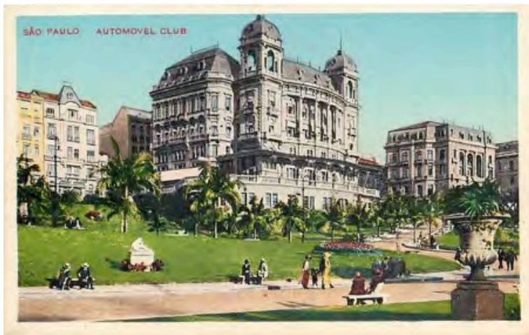
FIGURA 4.36 - São Paulo.. Automóvel Club. O parque finalizado e em uso. Nota-se a transição suave entre a rua Líbero Badaró e o fundo do vale proporcionada pelo talude. Cartão-postal colorizado, c.1920. E-bay.
