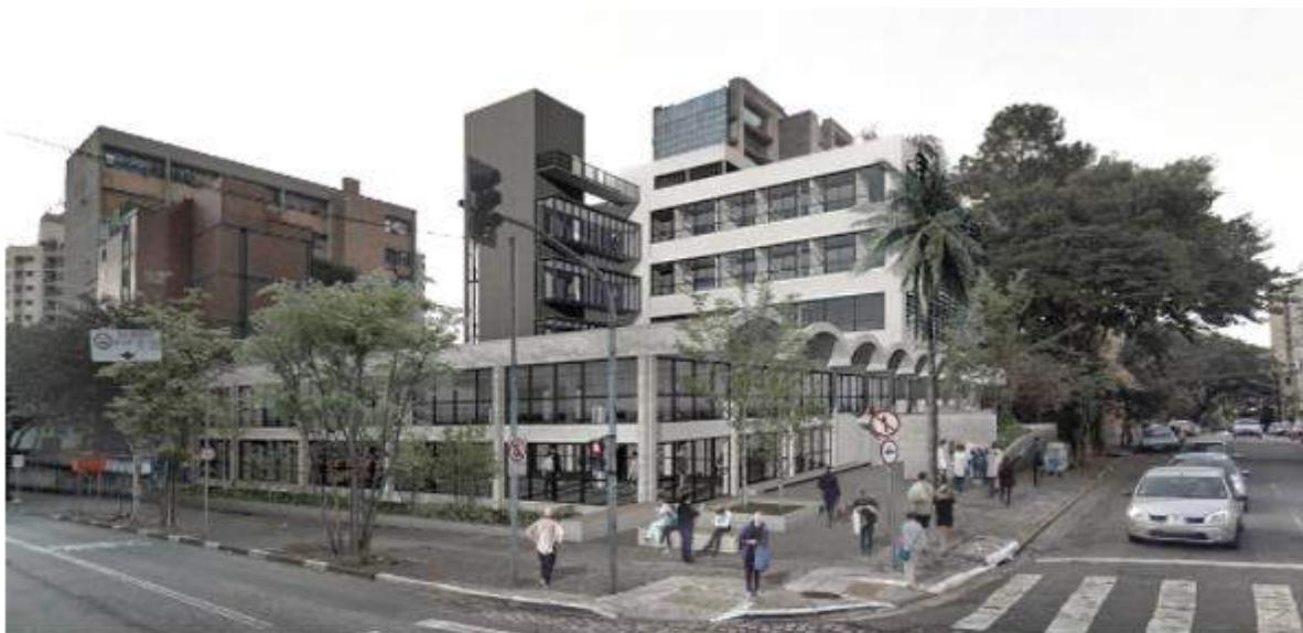
Figura. 6.4 - Obras de construção Centro Cultural em Saúde Unifesp, Campus São Paulo Fonte: Maquete eletrônica e fotos da fiscalização da obra, Unifesp, 2021
