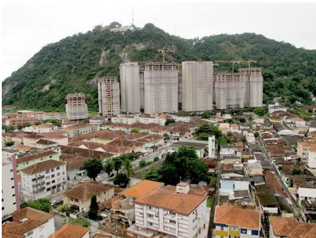
Figura 1. Construção de condomínio em área de casas e prédios baixos, no bairro do Marapé. Trata-se de uma área também próxima a duas estações do VLT.
